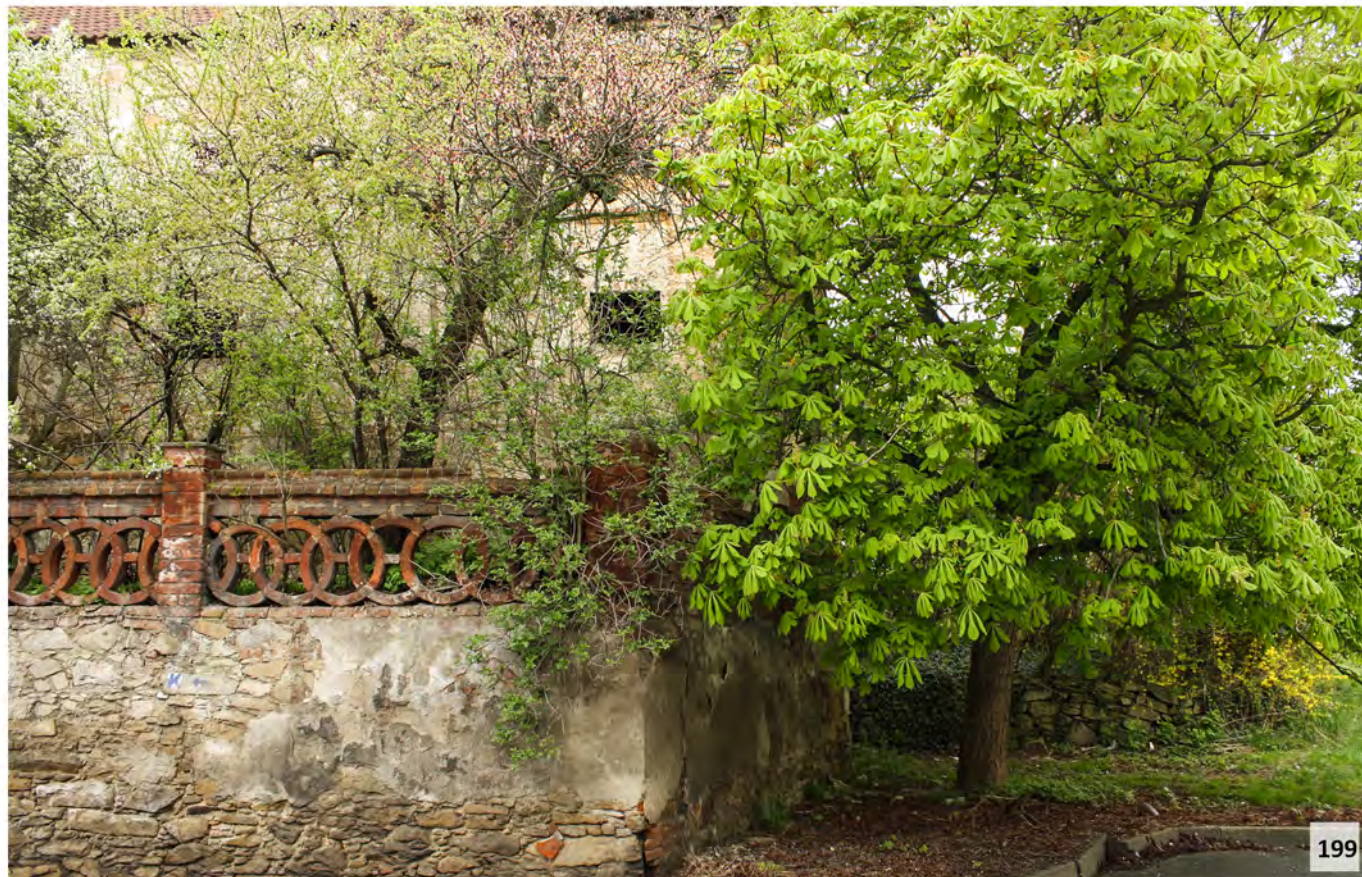
199 Kamenno-cihlová zeď. Štekeň, jižní Čechy.
