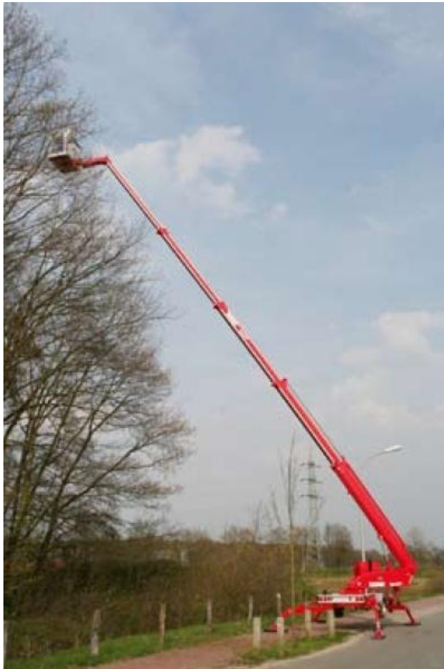
Obr.: 12.5. Využití vysokozdvizné mobilní pracovní plošiny
