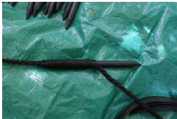
Instalace tlumiče rázů
