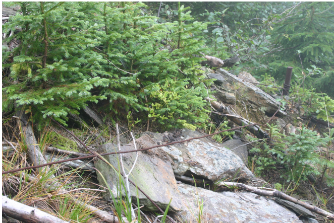
Ochranná síť vybudovaná v kombinaci s ploškově osazeným kamenivem tzv. ochranné sítě
