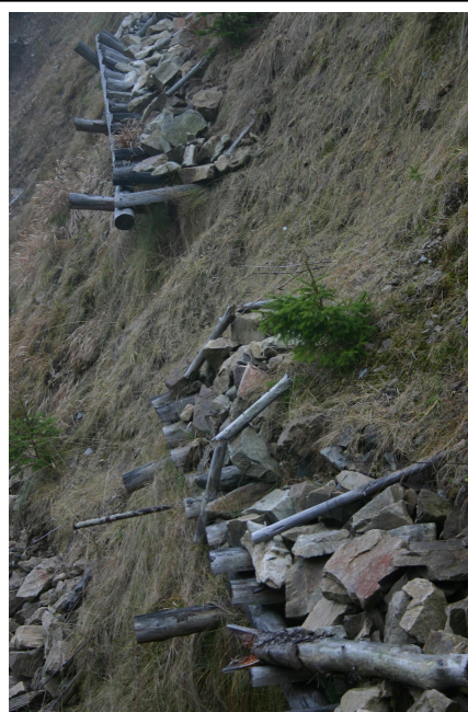
Soustava protierozních hrázek v prudkém svahu revír Malá Morava – Králický Sněžník
