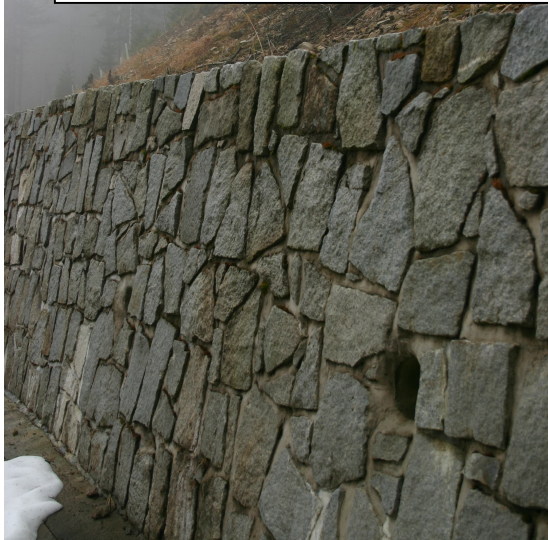
Opěrná zeď při plošném svahovém sesuvu v zářezu cesty po kalamitním odlesnění nad cestou v prudkém svahu Králický Sněžník
