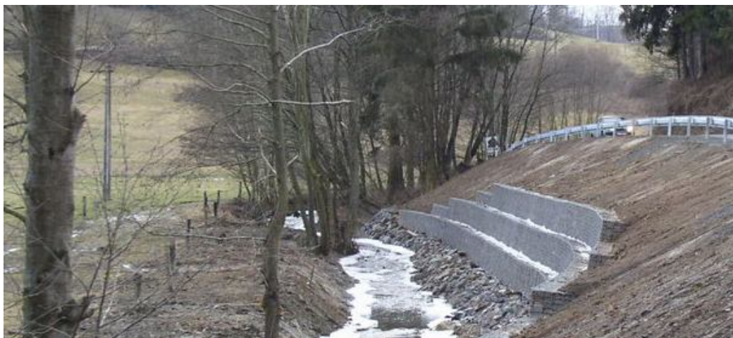
Opěrná zeď v soustavě porost, odvozní cesta jako terasa, vodoteč
