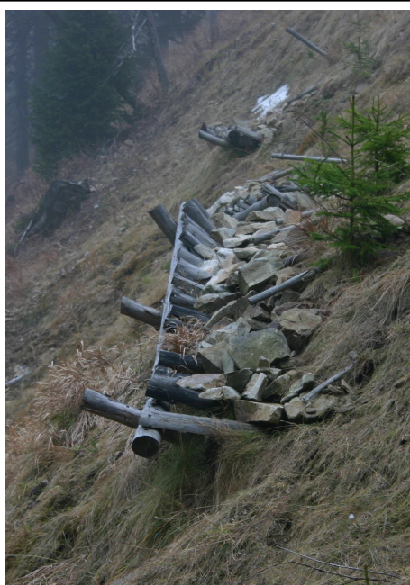
Protierozní hrázka – zához – kombinace kamene a dřevěného roštu Králický Sněžník - Stříbrnice
