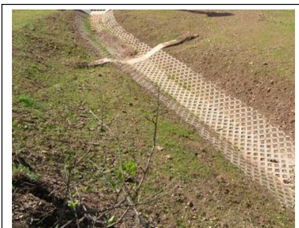
Nadstandardně vybudované průlehy s proti-erozní mřížkou
