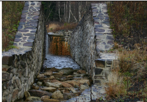
Opěrná zeď v navazující posloupnosti porostního svahu a vodoteče Krušné hory LS Klášterec
