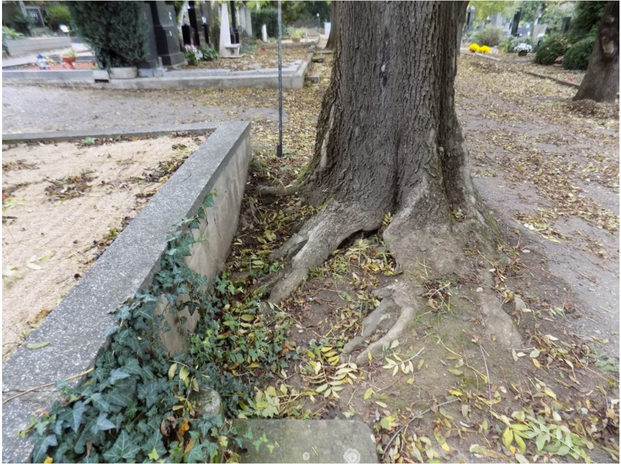
Obr. 4: Kolize báze stromů s hroby a vozovkou
