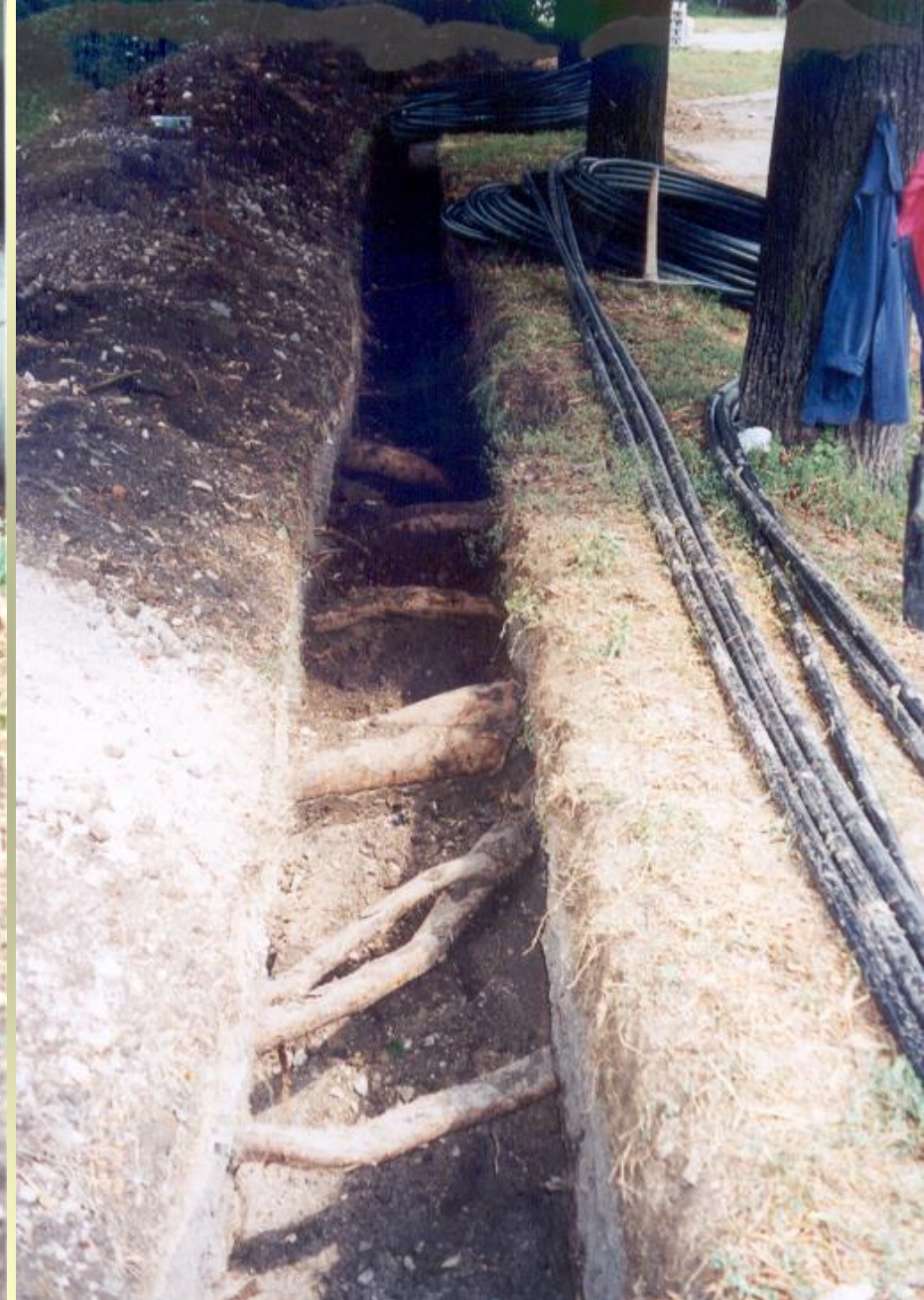
Pokládka elektrokabelů, ul. Stinná
