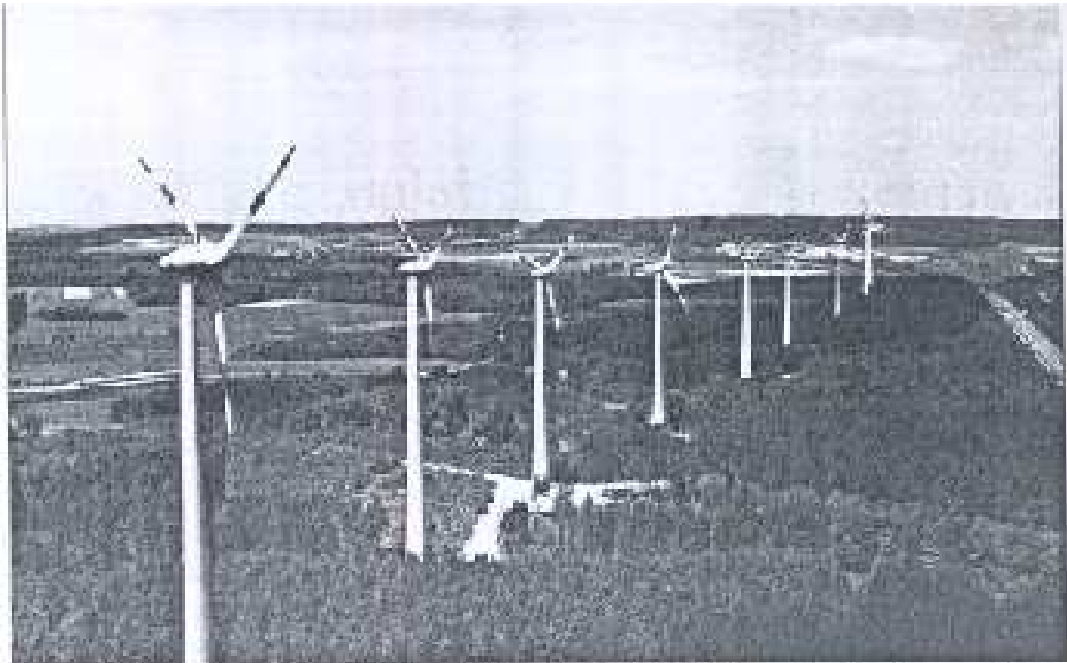
Der von juwi realisierte Windpark Kieselbach im Murrtal besteht aus zehn Windenergieanlagen, die zusammen pro Jahr 40 Millionen Kilowattstunden sauberen Strom erzeugen. Foto: juwi
