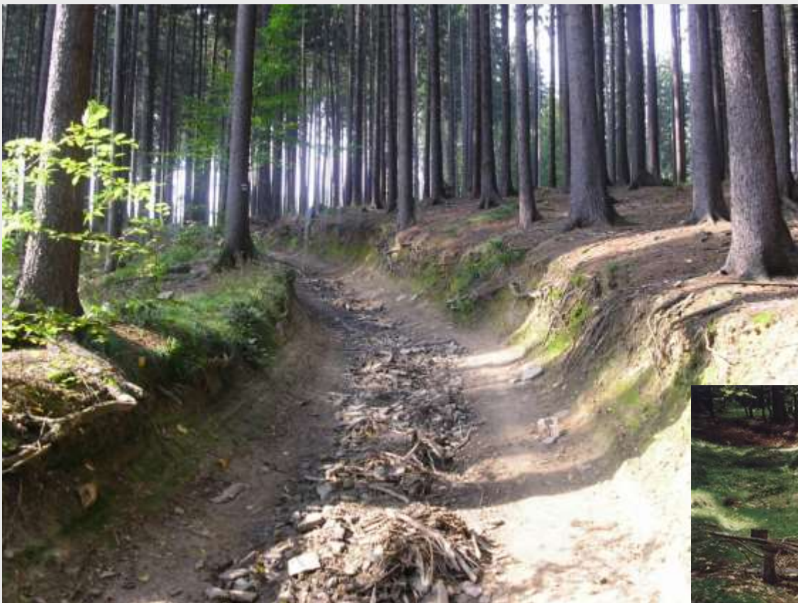
Sanace linky zahloubené pod úroveň terénu
