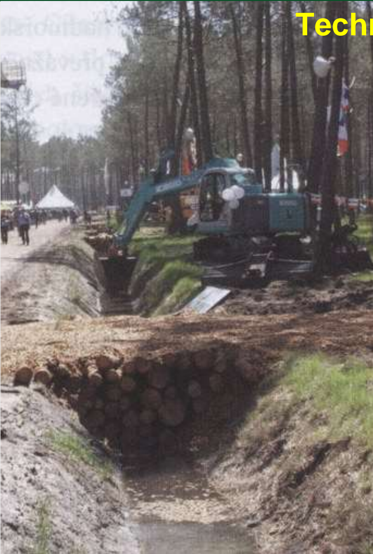
Jednoduché způsoby překonávání příkopů
