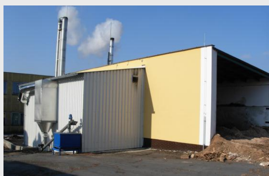
8. Teplárna na biomasu
