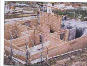
Obr. 2: Technika tupých spojů
