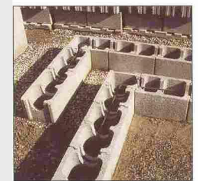
Obr. 2: Nároží z bednicích tvárnic
