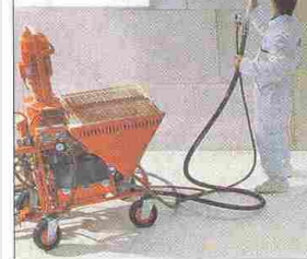
Obr. 3: Strojní omítání
