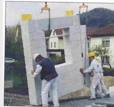
Obr. 3: Osazování panelů
