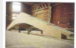
Obr. 3: Obloukové vazníky z lepeného vrstveného dřeva
