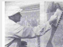
Obr. 149. Práce plechovým škrabádem
