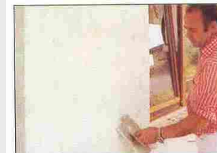
Obr. 2: Nanášení povrchové úpravy
