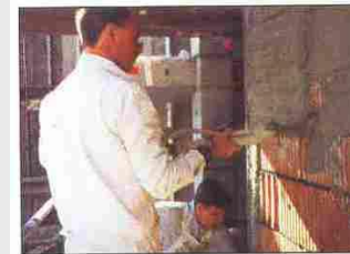
Obr. 1: Omítání omítkovou maltou
