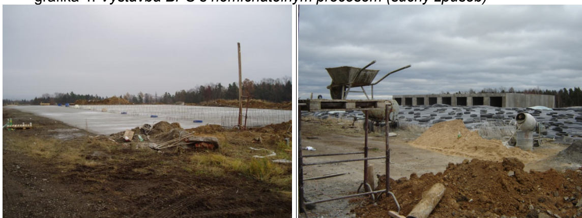
grafika 4: Výstavba BPS s nemíchatelným procesem (suchý způsob)
