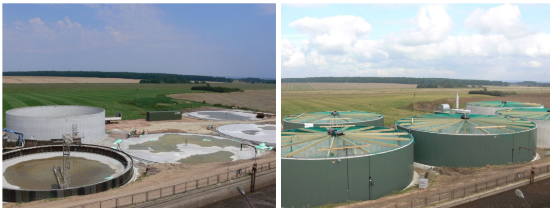
grafika 3: Výstavba BPS s míchatelným procesem (mokrý způsob)
