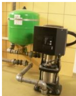
Vybavení laboratoře: Model oběhového čerpadla a ventilu, stanice pro zvyšování tlaku
