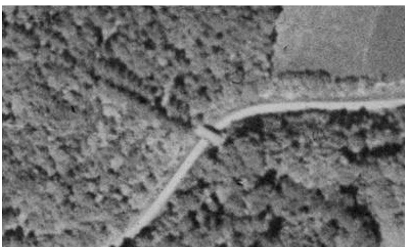
obr. 9: Detail přemostění silnice na historickém leteckém snímku. Podkladové letecké snímky poskytl VGHMÚŘ Dobruška, © MO ČR 2009.
