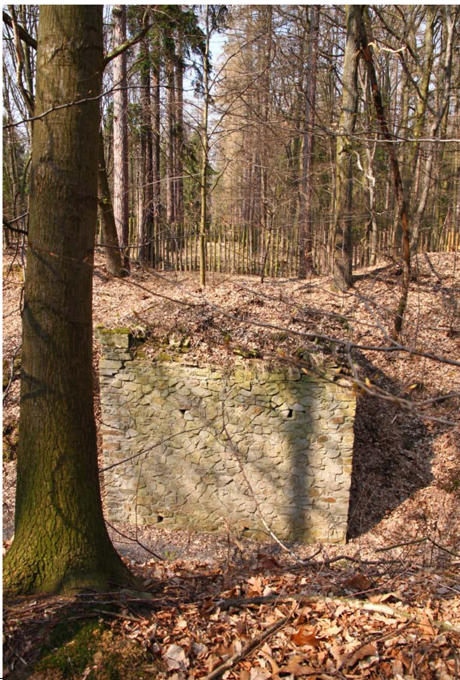
obr. 27: Přemostění silnice v ose na drahobudický kostel. Foto M. Flekalová, 2012.
