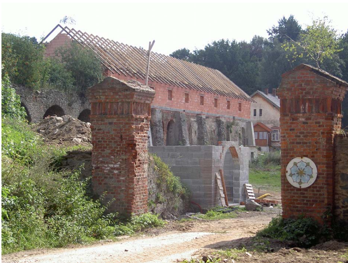
obr. 30: Hospodářský dvůr Na Polánce během oprav. Foto D. Vítovská. 2006
