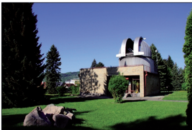
Obr. 1: Budova odborného pracoviště valašskomeziříčské observatoře
