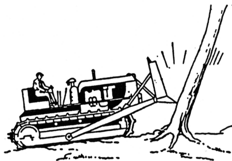
Technologický postup při odstraňování stromů do průměru 25–30 cm.
