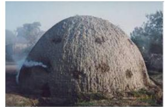
Slow pyrolysis (kiln)
