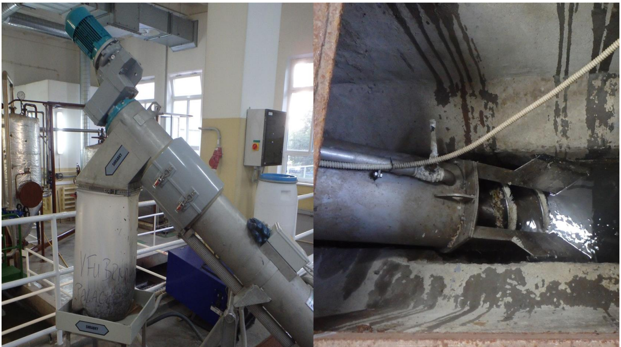
Obr. č. 41 Rotační šnekové česle
