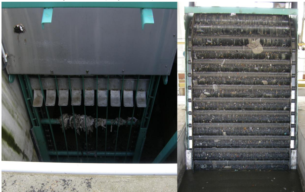
Obr. č. 42 Hrubé a jemné česle (strojně stírané)
