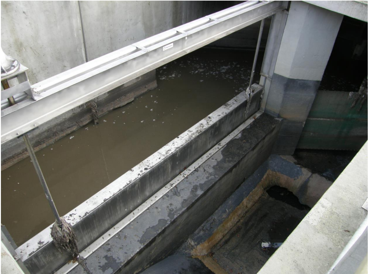
Obr. č. 40 Odlehčovací komora (ČOV nad 100.000 EO)
