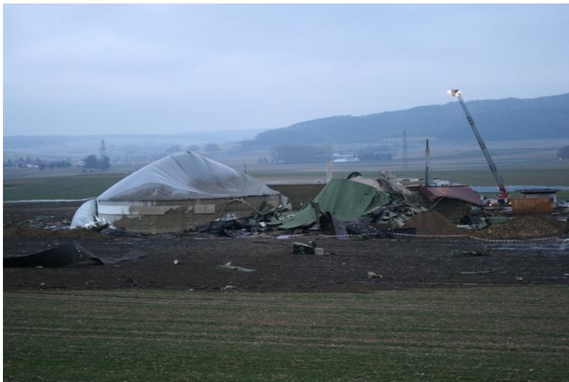
Obrázek 51: Následky výbuchu v bioplynové stanici v obci Daugendorf (Německo)
