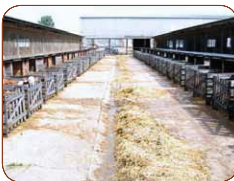
Obrázek 40: Perfektně spádovaná podlahy venkovní odchovné plochy
