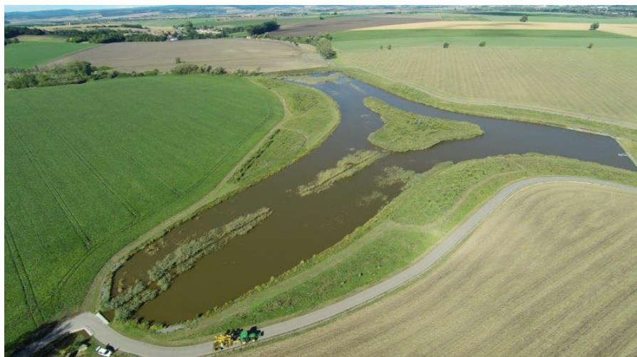
Obr. 55 Ukázka realizace malé vodní nádrže se stálým nadržáním (zdroj: SPÚ)
